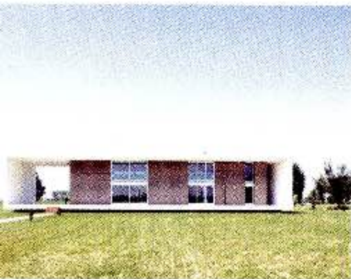
autor / progettista_ andrea oliva saracnici / collaboratori_ david zilloli - luca paroli delo / opera_ casa sulla morla impresa esecuttrice_ imp. f. li menza. lokacija / localita'_ castelnuovo sotto- reggio emilia. realizacija / anno realizzazione_ 2008. fotografie_ ka-uwe schuitje-bunert.
