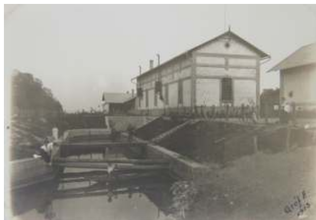
3. Фотографија црпне станице из 1913. године, припадала је Музеју вода инжењера Николе Миркова, Сремска Каменица 3. Photograph of the Pumping Station taken in 1913, previously belonging to the Museum of Water of engineer Nikola Mirkov, Sremska Kamenica
