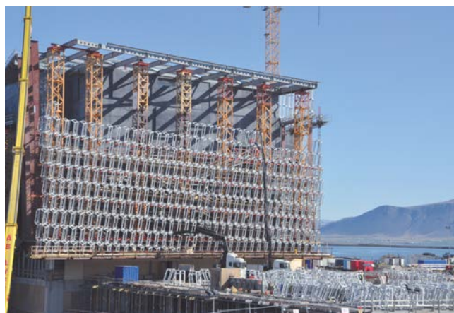
2. Изградња јужне фасаде, 2006–2007.
